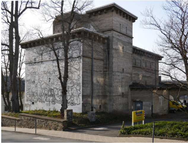
Abb. 3 Hochbunker an der Burgstraße mit Turm, Konsolfriesen und Gesimsen, 1940/41, Foto 2022
