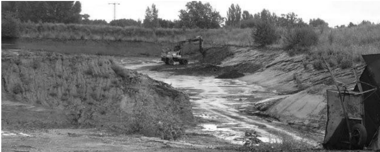
Abbildung 49: Ein Bagger entfernt Bitumen aus einem Erdgrubenlager (Archivbild STRABAG SE)
